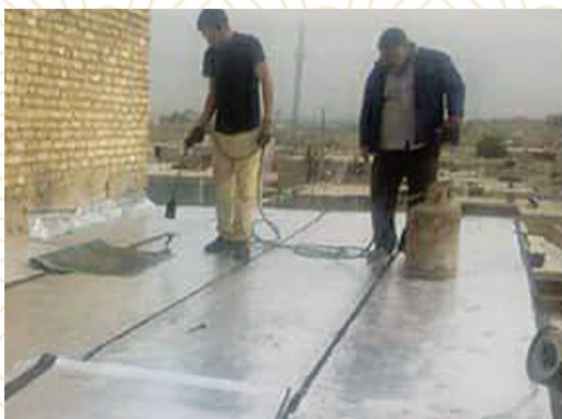
بازسازی منازل آسیب دیده در منطقه کوی الصافی
