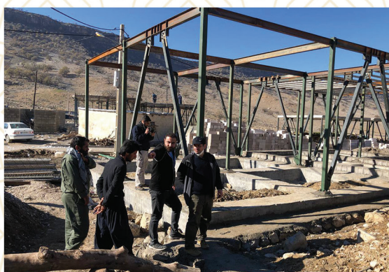
ساخت ۳۰ چایگاه دام در دو روستای زلزله‌زده اندیکا (گرداب و کلاک چلو)
